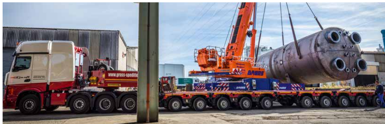
Umschlag eines Kammer-Tanks.
