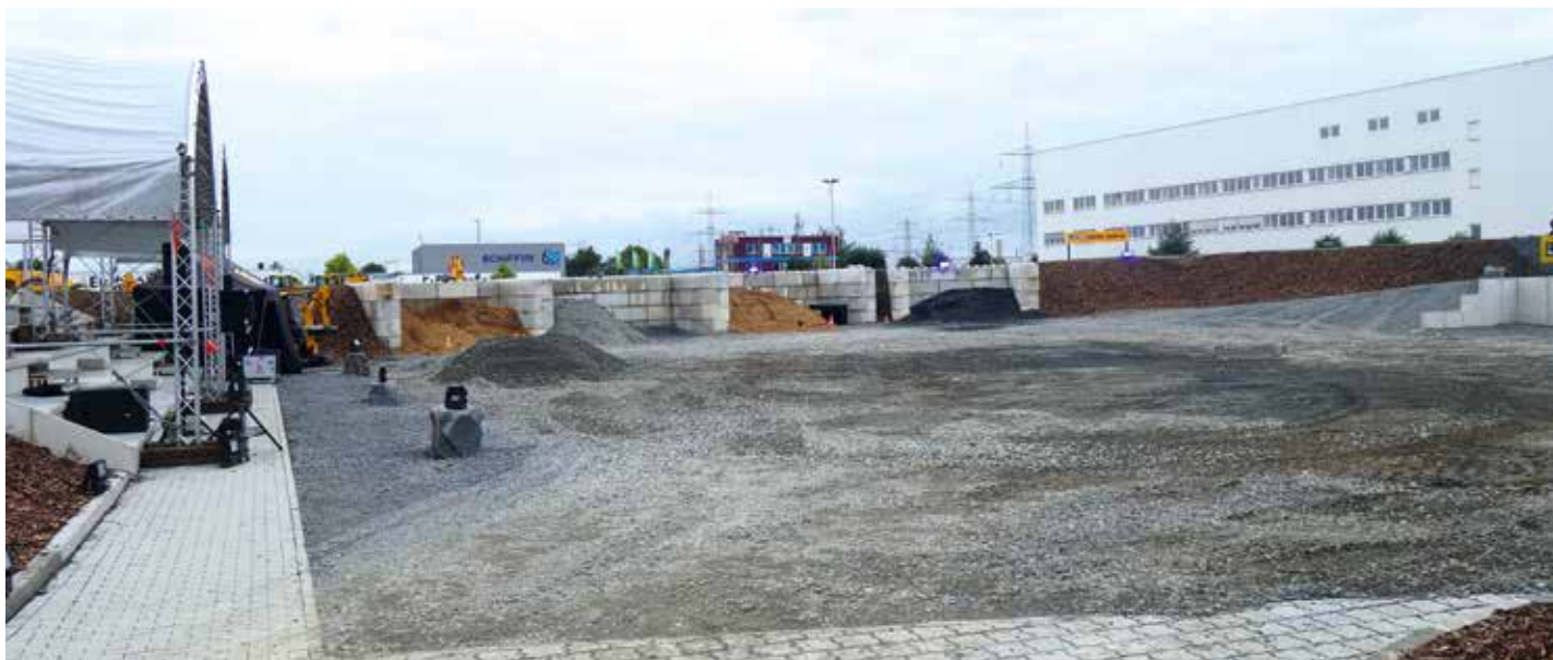
Das Testgelände war auch Schauplatz ...
