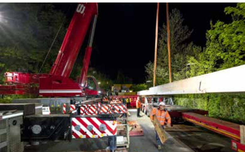
Los geht's: zwei Krane, darunter ein LTM 1250-5.1, verladen die Last auf einen Tieflader.
