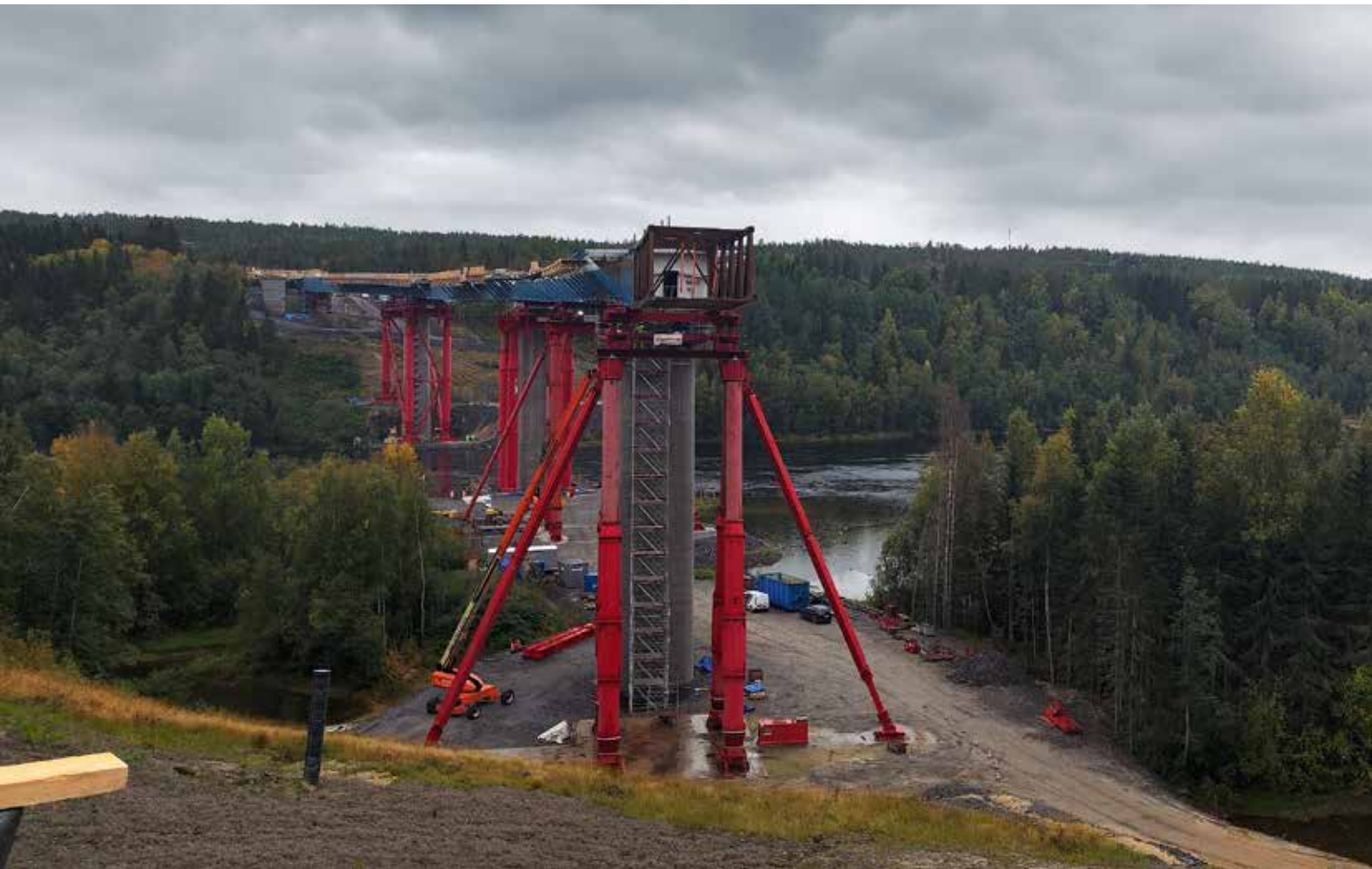
Temporäre provisorische Stütztürme.
