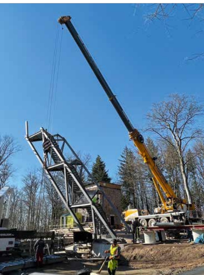
Der fertige Irene-Aussichtsturm mit 45° Schräglage – eine Herausforderung für die Konstrukteure und die Montage-Mannschaft.
