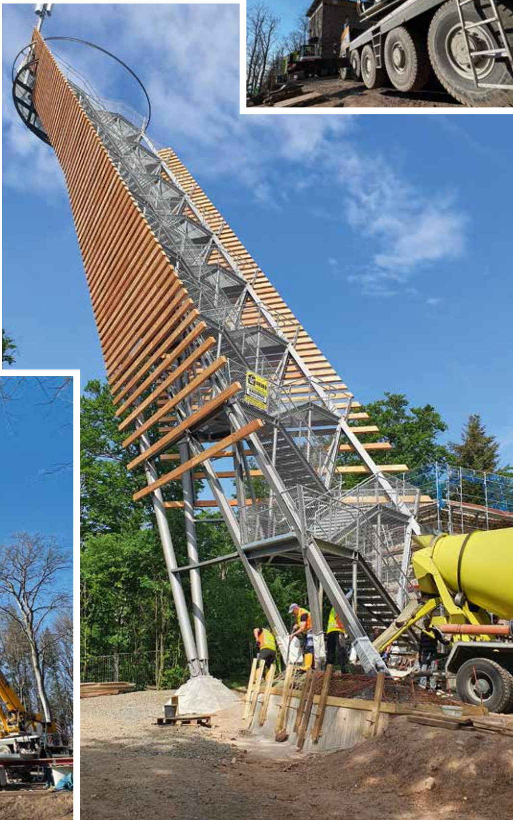
Der fertige Irene-Aussichtsturm mit 45° Schräglage – eine Herausforderung für die Konstrukteure und die Montage-Mannschaft.
