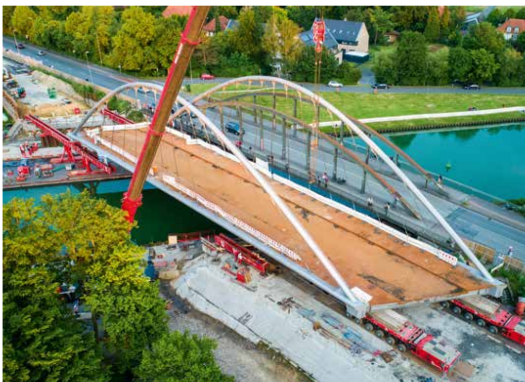
Außergewöhnliches Design, eine asymmetrische Brücke.
