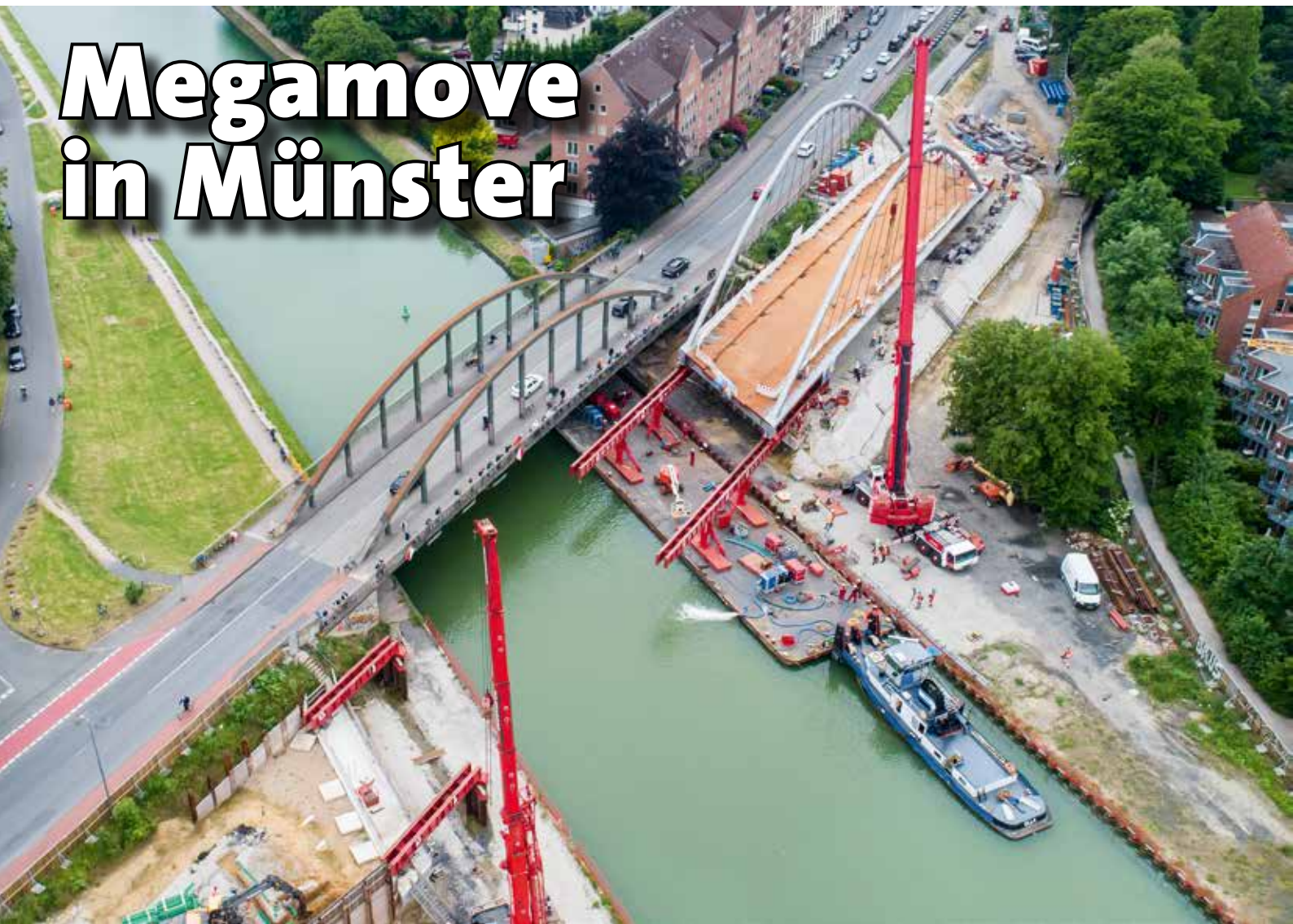
Montage der neuen Brücke über den Dortmund-Ems-Kanal in Münster.
