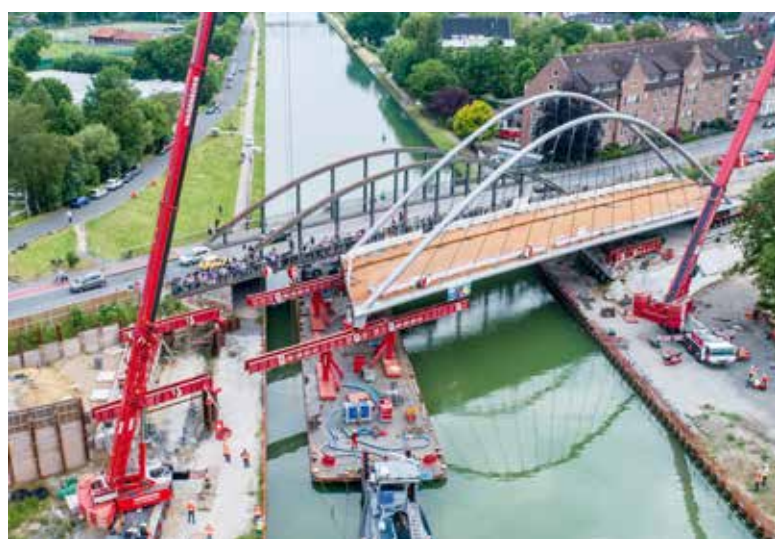
Fast geschafft, Brückenmontage von Wagenborg Nedlift.
