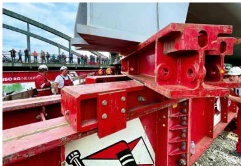
Kombinierte Techniken bei der Brückenmontage.
