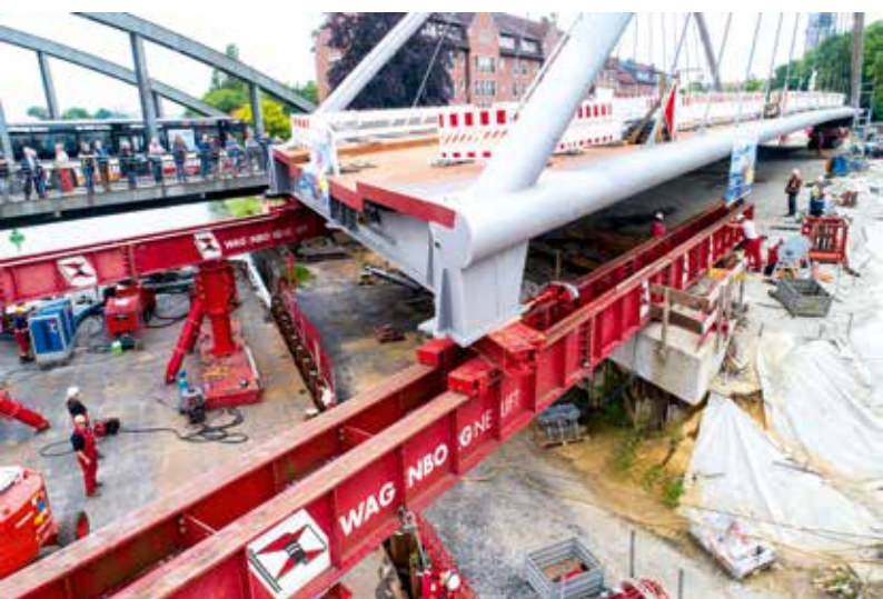
Der erste Teil des Schiebevorgangs beginnt.
