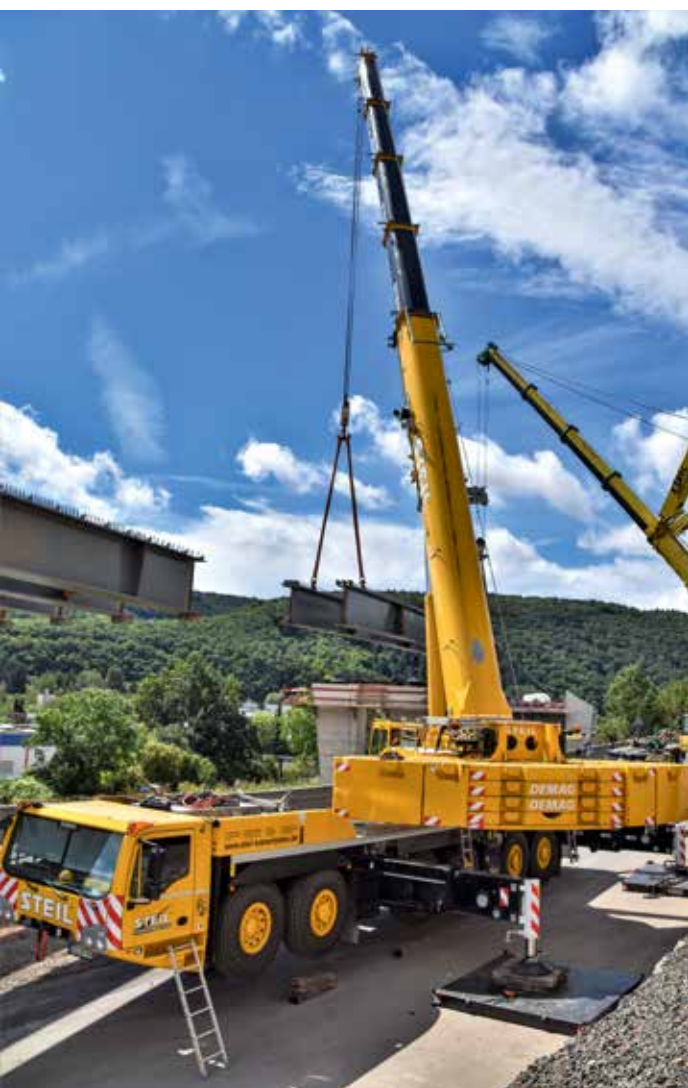
Bereit für den Brückenschluss.
