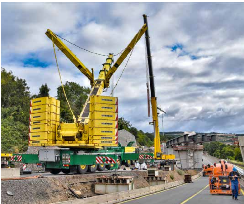
Um die Krane positionieren zu können, mussten Fundamente eingebracht werden.
