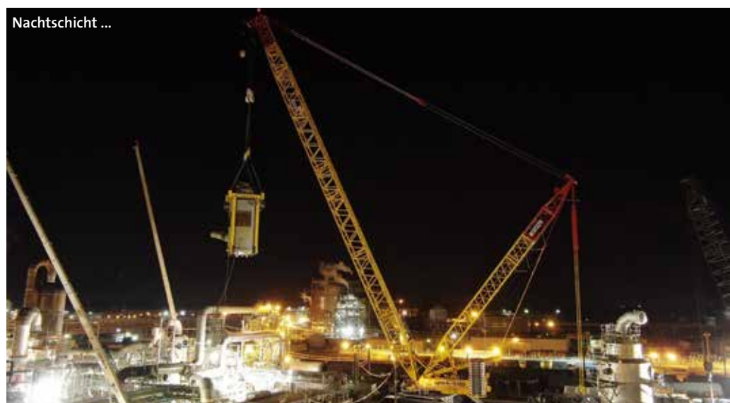
Hier wurde der Superlift-Ballast vom Kran getrennt.
