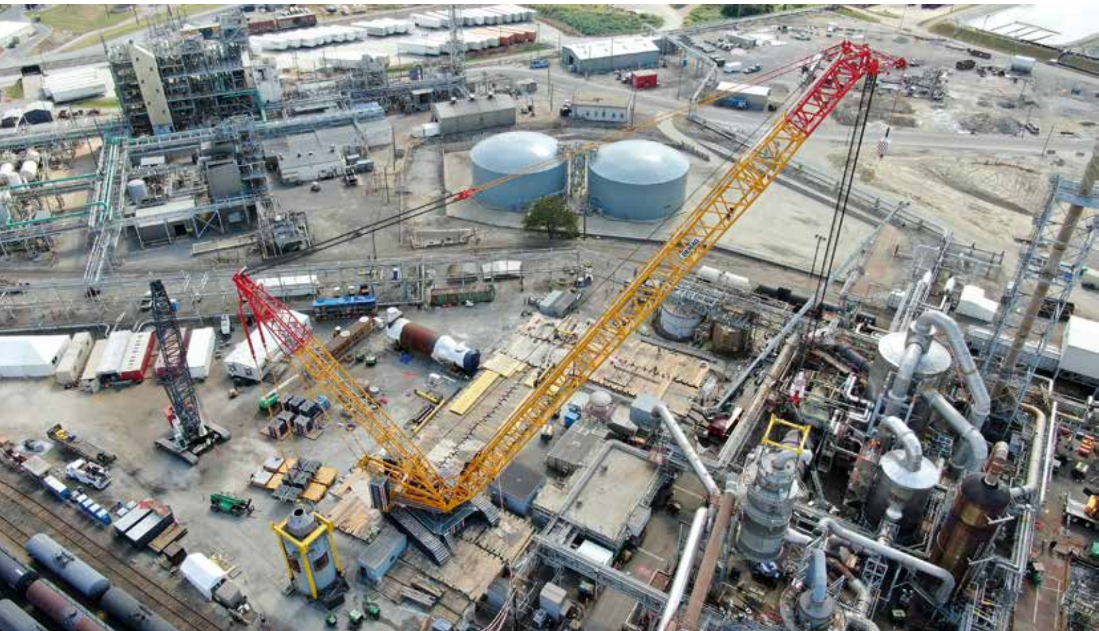
Zum Einsatz kam der CC 6800-1 mit 79 m Hauptausleger und 41 m Superlift-Ausleger.
