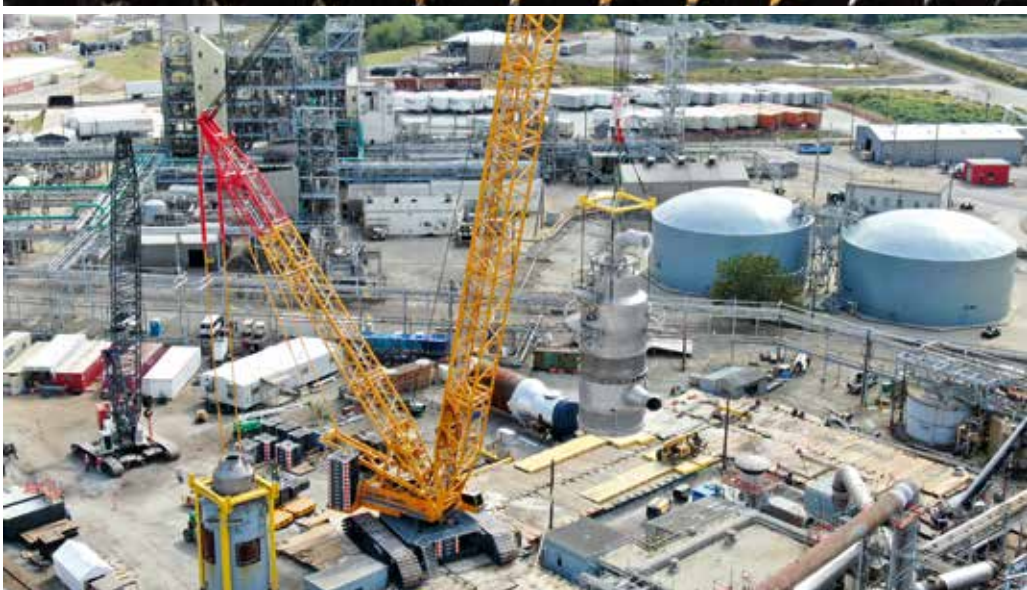
308 t wogen die Behälter, die in diesem petrochemischen Werk ersetzt wurden.
