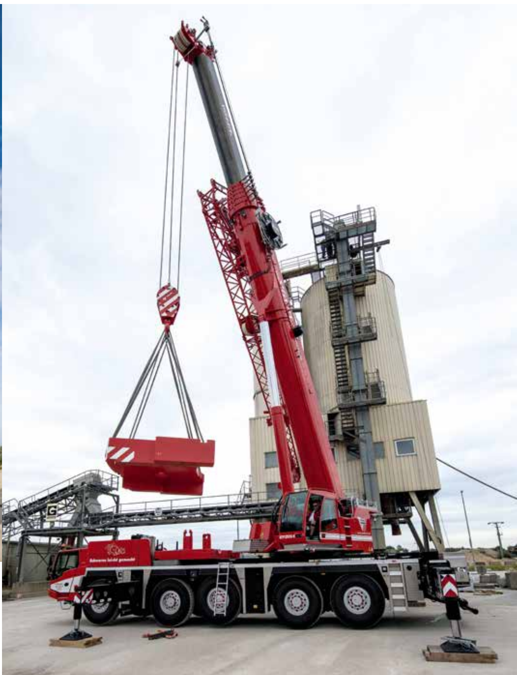
Der 220-Tonner wird gerüstet.
