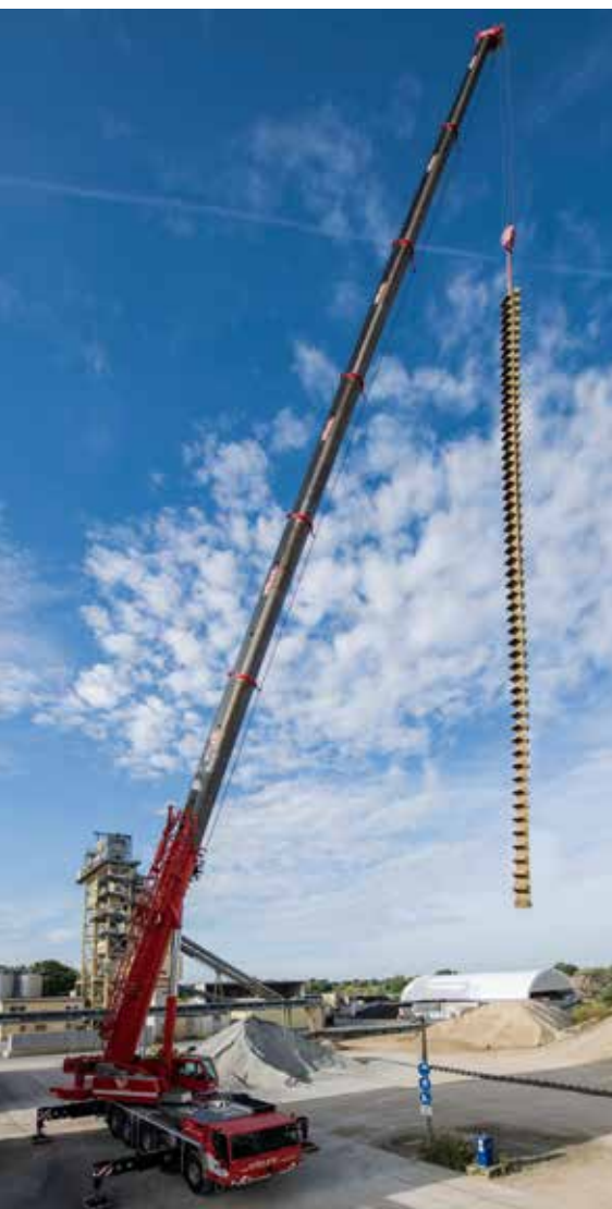
Fördergurt am Haken: Der Gurt brachte es auf ein Gewicht von 6,8 t bei einer Länge von 30 m.
