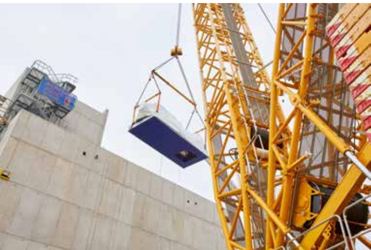
Einhub der 45 Tonnen schweren Turbine in das neue Heizkraftwerk. Zentimetergenau wird die Turbine zwischen den Wänden des Turbinenraumes abgesenkt.
