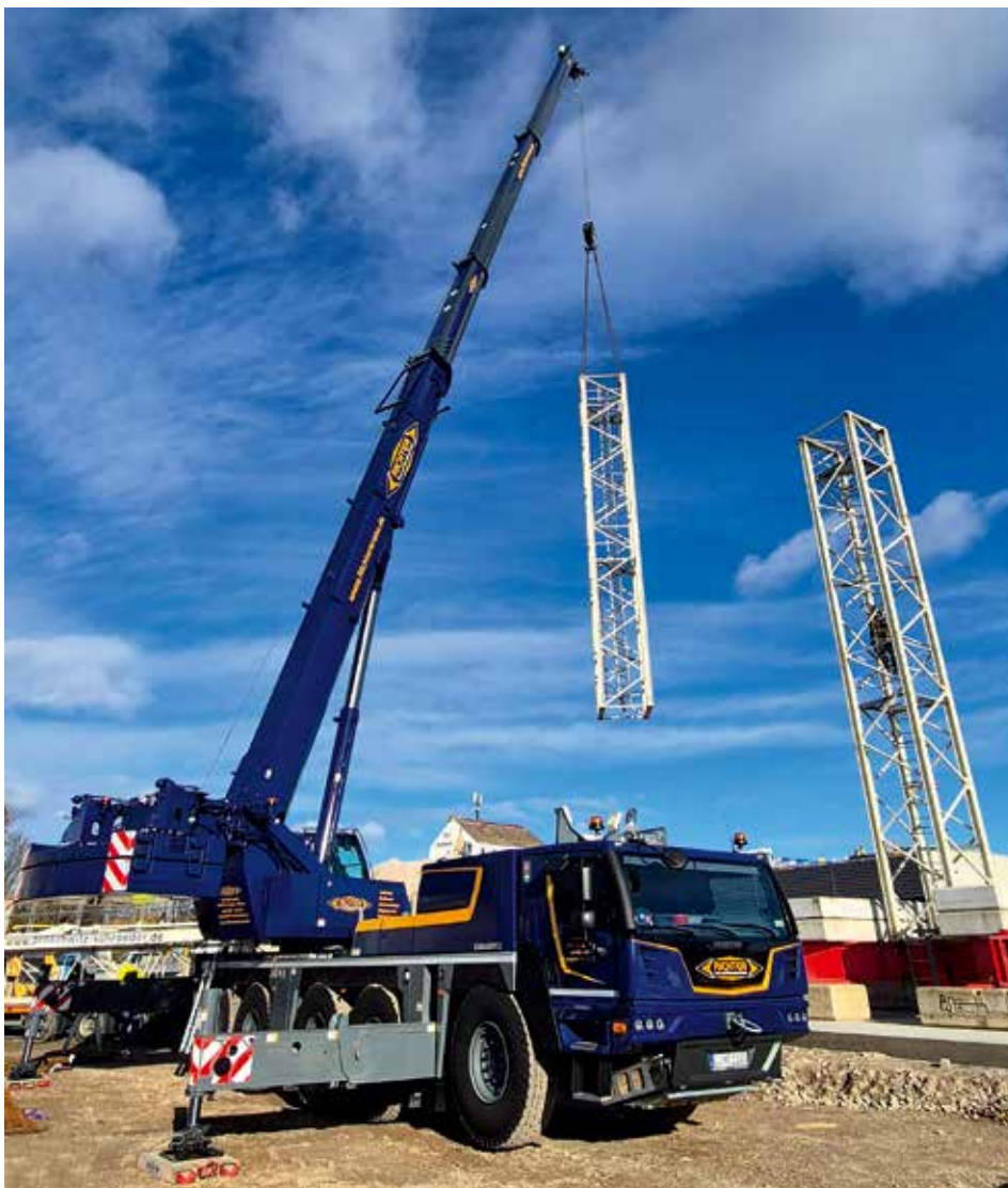
Ersteinsatz: Der LTM 1100-5.3 von Richter Kran montiert einen Turmdrehkran.
