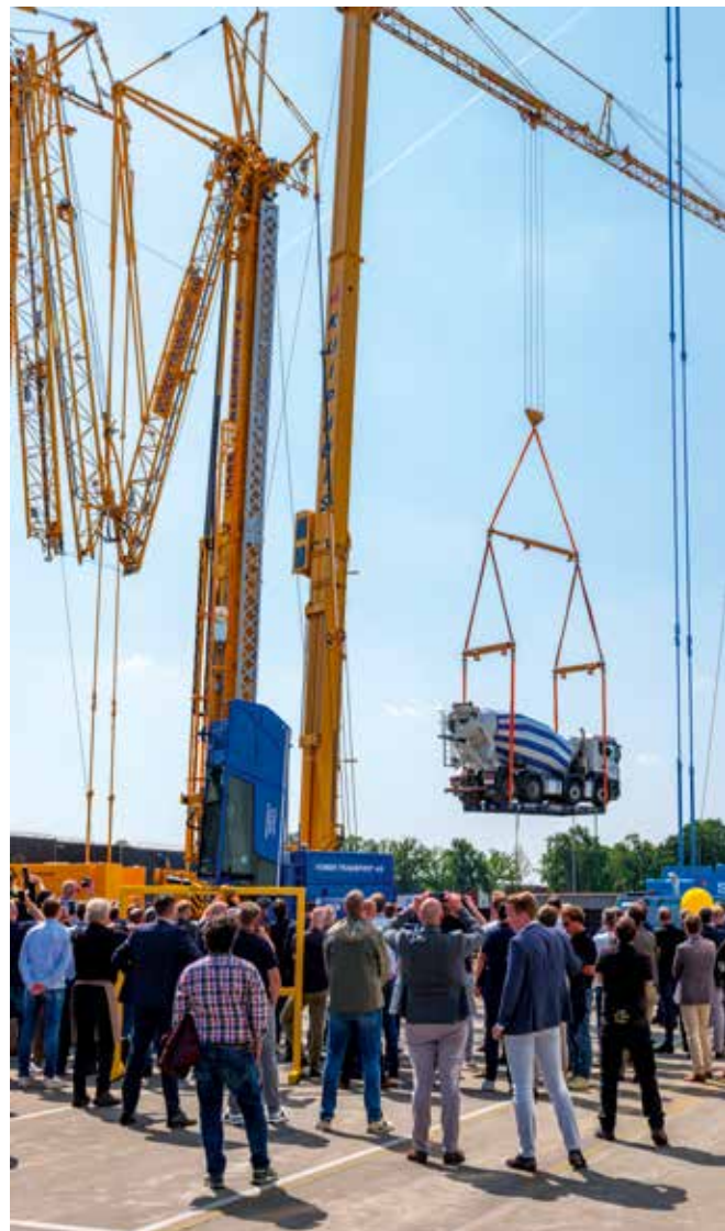
„Kranballett“ mit schwerer Last.
