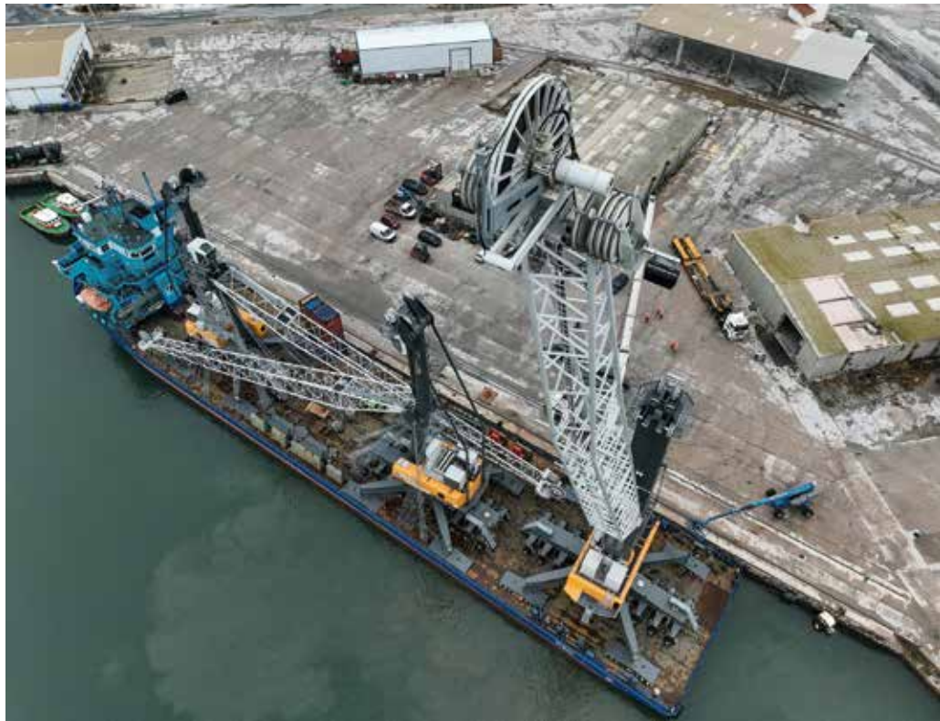
Im Hafen von Castellon angekommen, machen sich die drei Liebherr-Hafemobilkrane bereit für die Entladung in Spanien.
