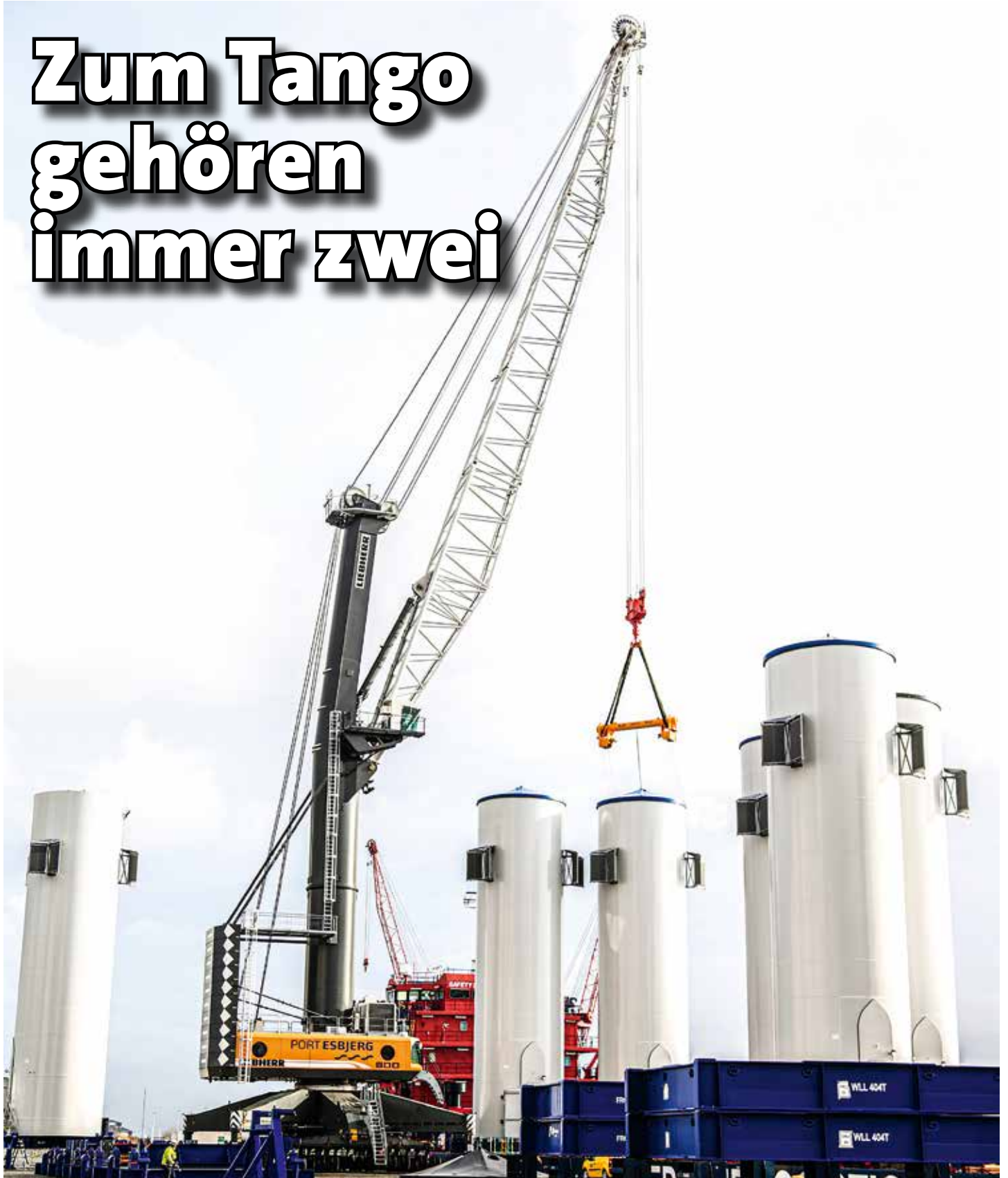
Der Liebherr LHM 800 im Einsatz in Port Esbjerg.
