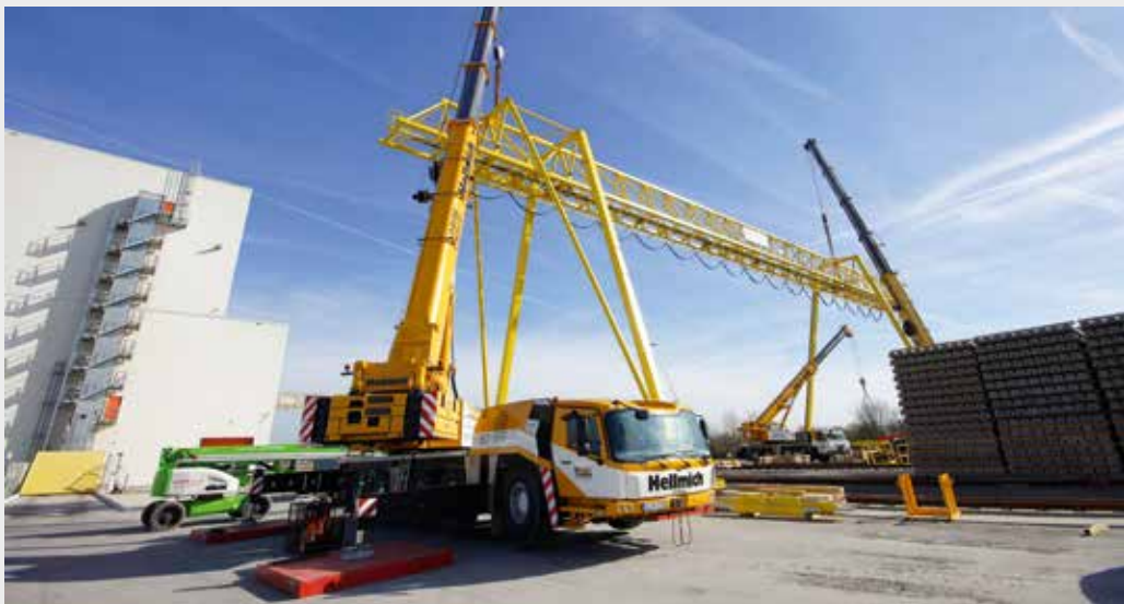
Montage eines Portalkranes für eine Eisenbahnschwellen-Fabrik.
