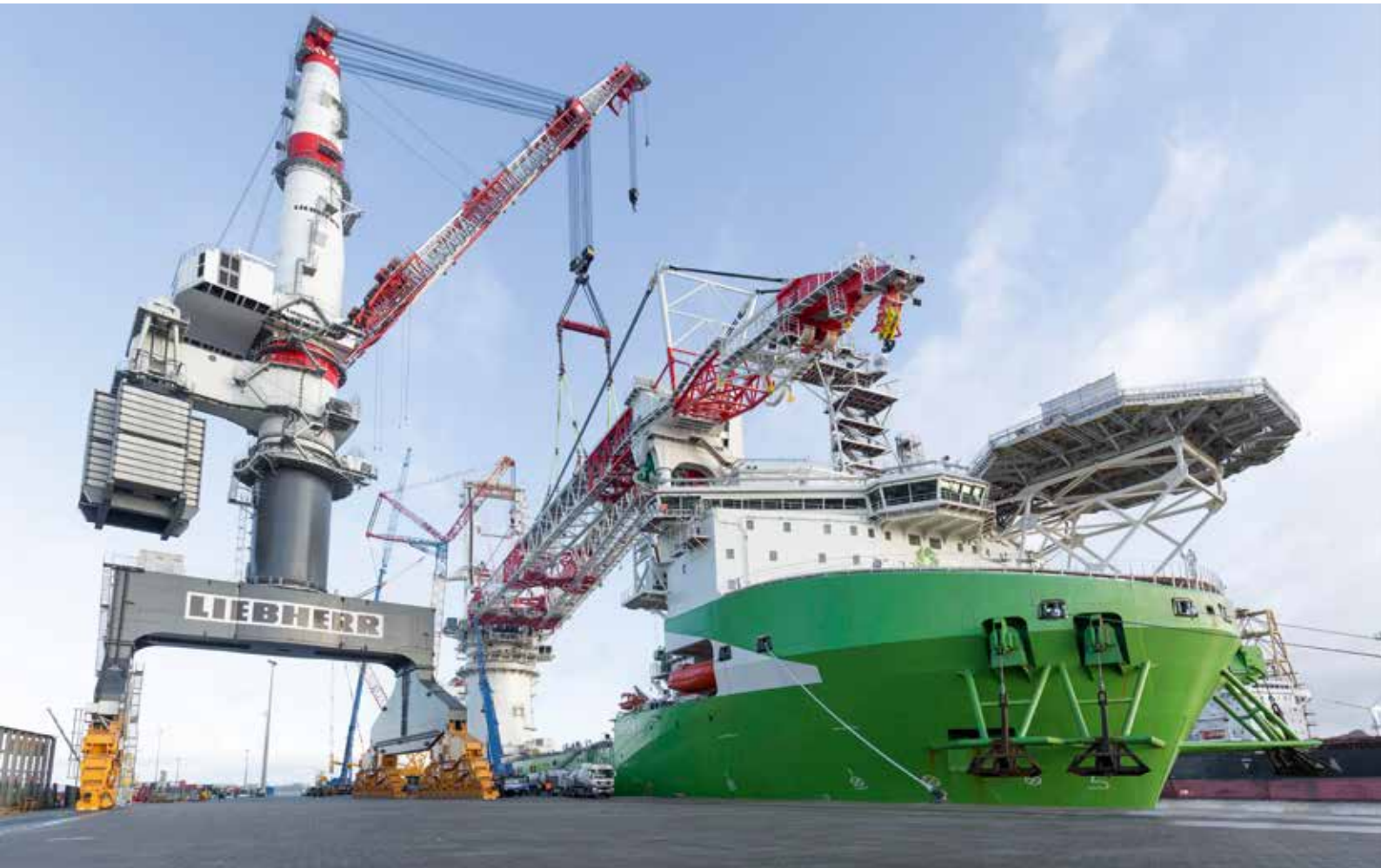
Liebherr's leistungsstärkster Kran kommt aus dem Offshore-Bereich: Der HLC 295000 wird auf das Offshore-Installationsschiff Orion montiert. Bei der Installation einzelner Großkomponenten hilft der Liebherr-Portalkran TCC 78000.
