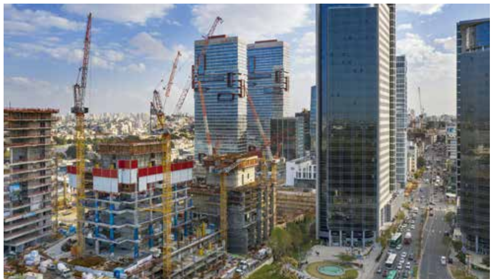
Starke Kranflotte in Tel Aviv: Liebherr-Turmdrehkrane werden für den Bau des dreitürmigen LYFE-Geschäftskomplexes in der industriellen Zone Bnei Brak in Israel eingesetzt.
