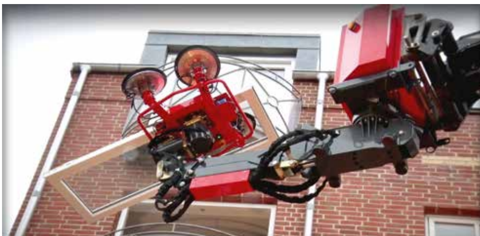
Schnell und sehr präzise, der Litocran zur Montage von Fenstern und Fassadenteilen.
