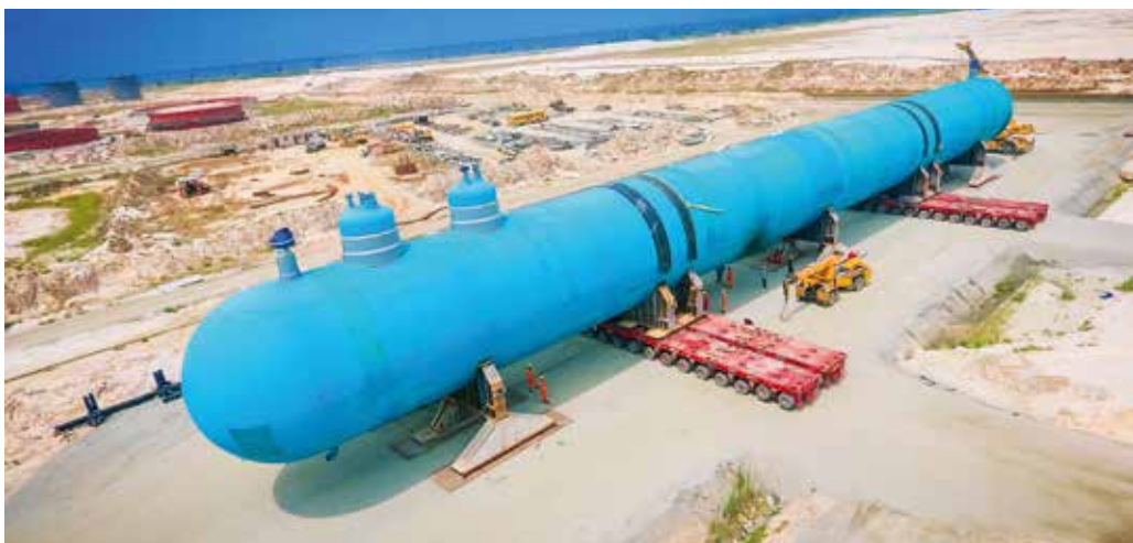
Mit dem Transport und der anschließenden Montage dieses 1.240 t schweren Propylen-Anlagenteils hat Mammoet die Arbeiten in der Dangote-Raffinerie abgeschlossen.
