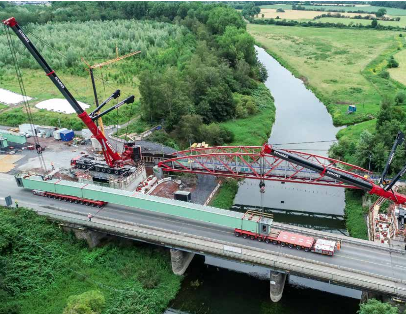
Zwei 500 t-Mobilkrane heben gemeinsam das Brückenteil vom SPMT und positionieren es auf den Widerlagern.
