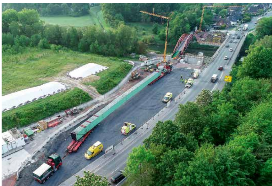
Der erste Brückenträger wurde bereits von Plauen nach Bergkamen geliefert und dort auf der Baustelle zwischengelagert. Bis Anfang Juni folgten noch zwei weitere.
