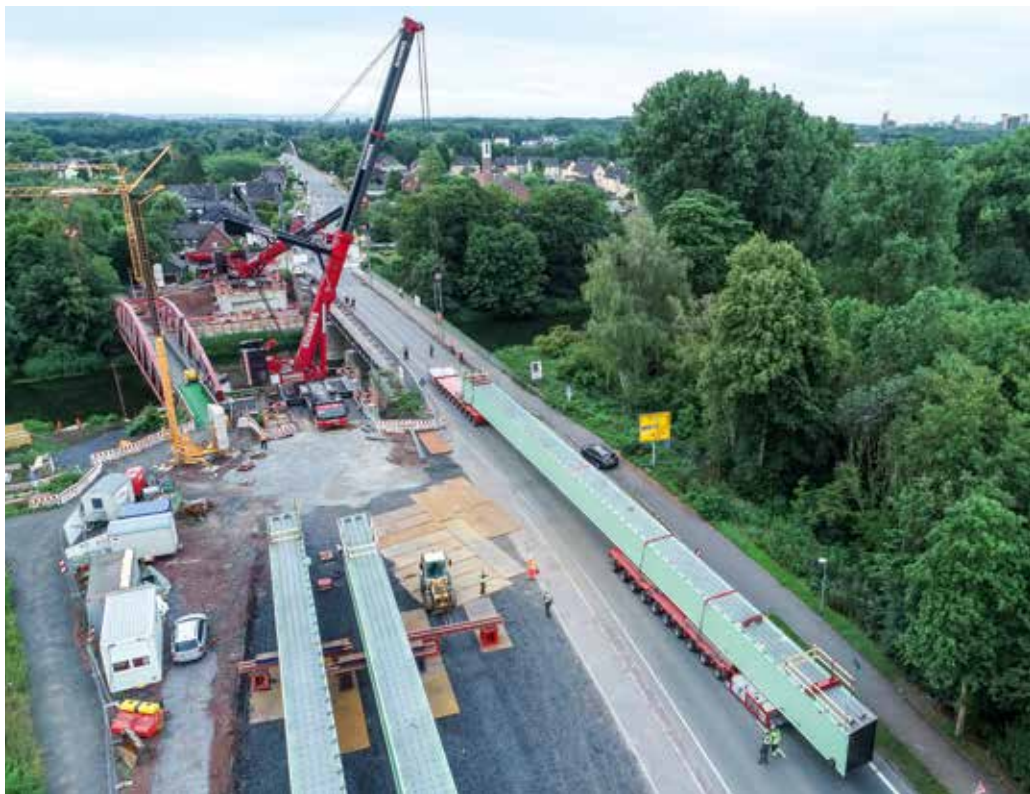
Der erste von drei Brückenträgern wird von Kahl auf SPMT auf die Bestandsbrücke transportiert.
