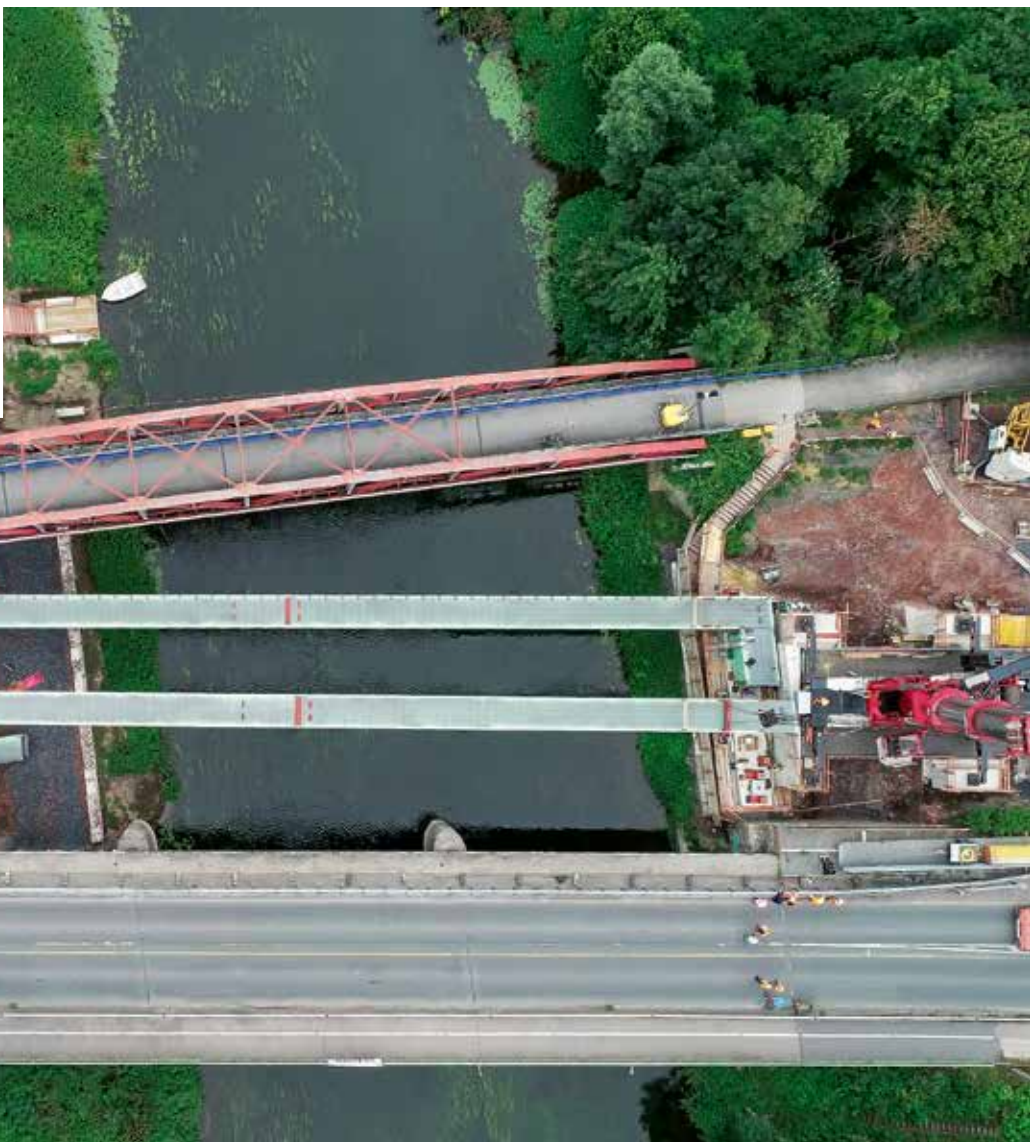
Der erste von drei Brückenträgern wird von Kahl auf SPMT auf die Bestandsbrücke transportiert.
