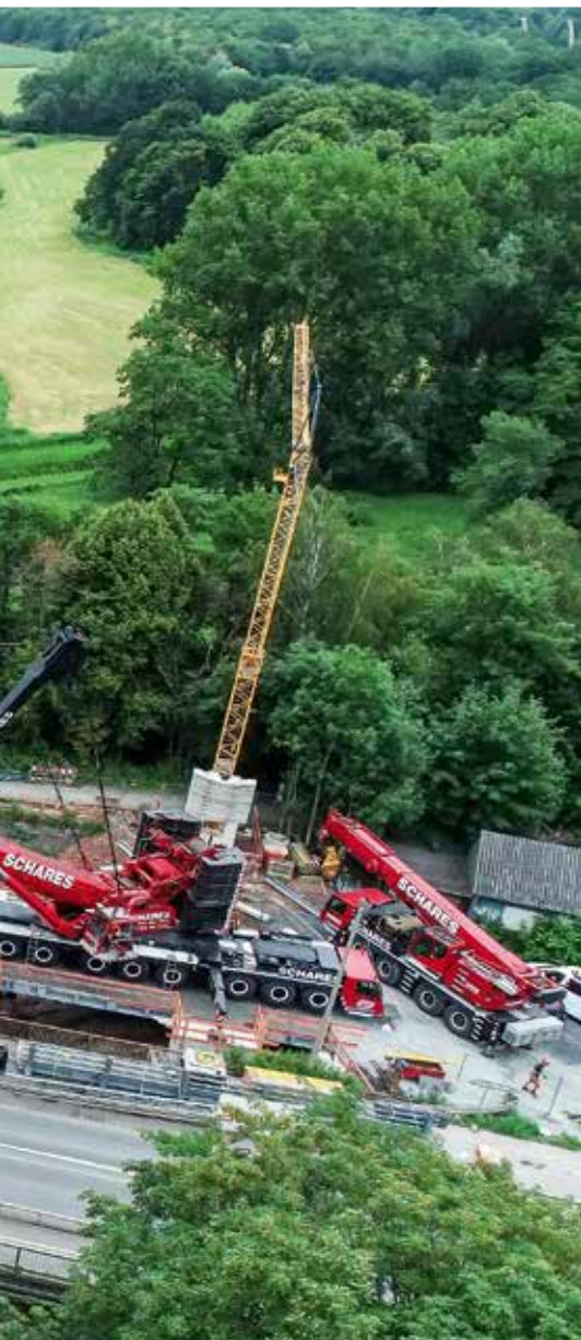
Der erste von drei Brückenträgern wird von Kahl auf SPMT auf die Bestandsbrücke transportiert.
