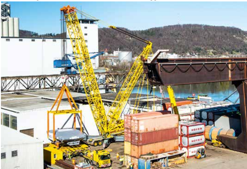
Der TC 2800 von Wolti-Furrer übernimmt hier das Handling der Last. Foto Lukas Pitsch/proimagehub.ch
